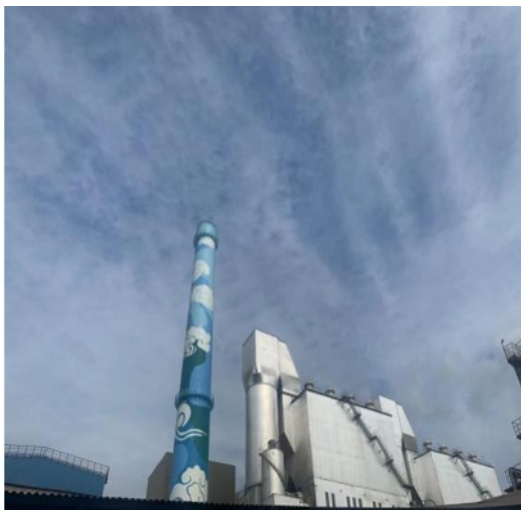
2X220m 2 烧结脱硫脱硝
