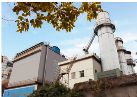
三炼钢电炉布袋除尘
