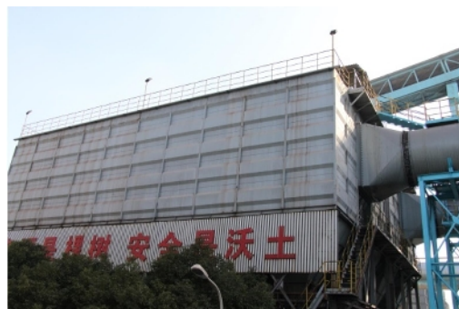
二铁厂 5#高炉炉前除尘
